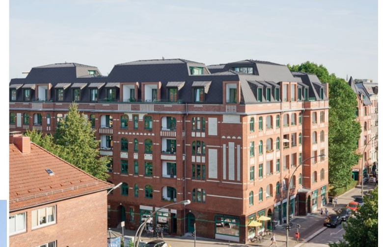
Denkmalgeschütztes Gebäude mit Aufstockung, Hamburg
